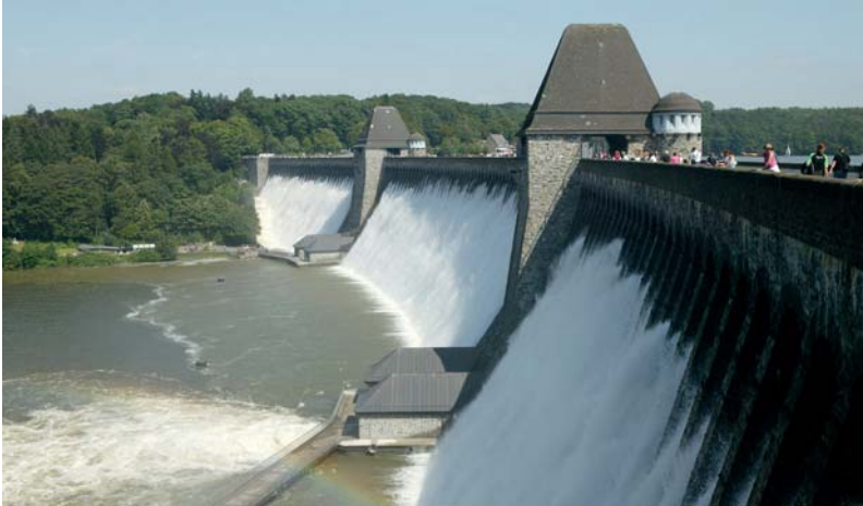
Bild 5. Praxisnahe Forschung: Bemessung wasserwirtschaftlicher Anlagen (hier die Hochwasserentlastung einer Talsperre).
