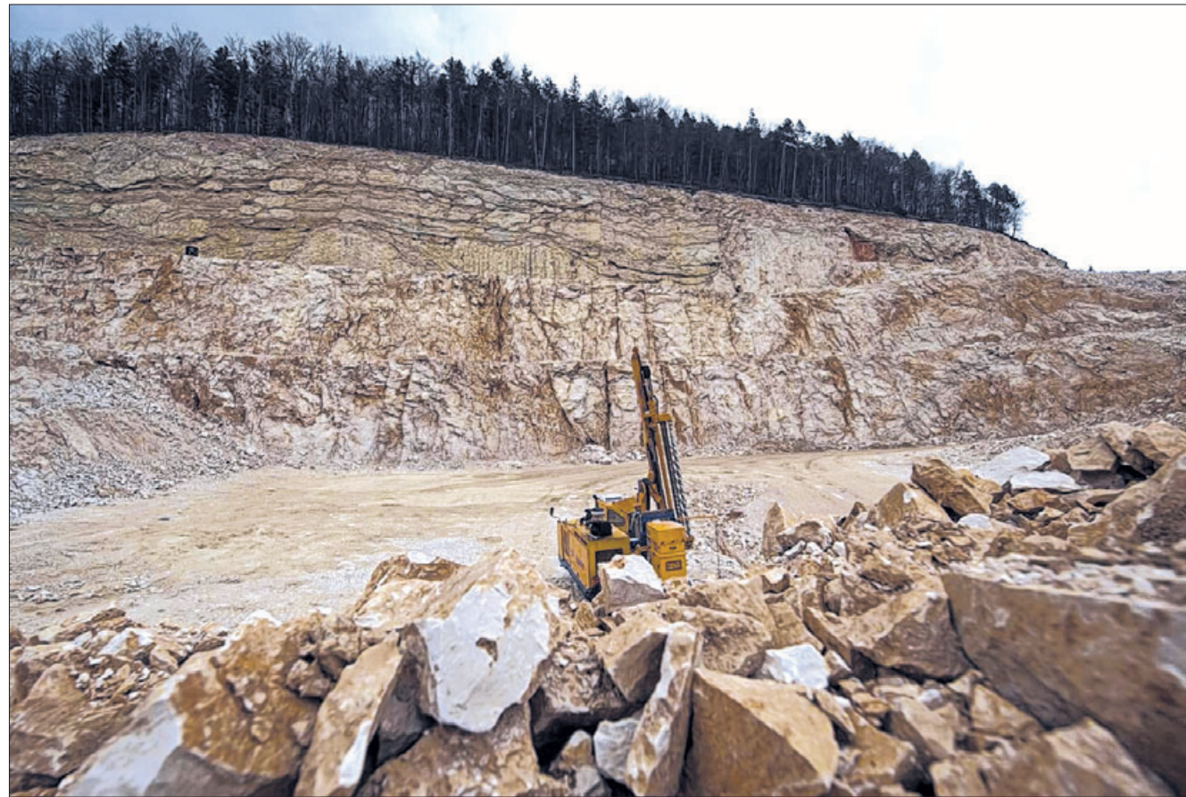
Der auf dem linken Foto sichtbare Bereich des Steinbruchs der Firma Eduard Merkle soll weiter abgesenkt und als Unterbecken eines Pumpspeicherkraftwerks eingerichtet werden – bis etwa zehn Meter unter dem Grundwasserspiegel. Interessierte konnten sich am Montag im Steinbruch unter sachkundiger Führung (rechtes Foto) über die Lage und die Planung des Unterbeckens informieren. Fotos: Matthias Kessler
